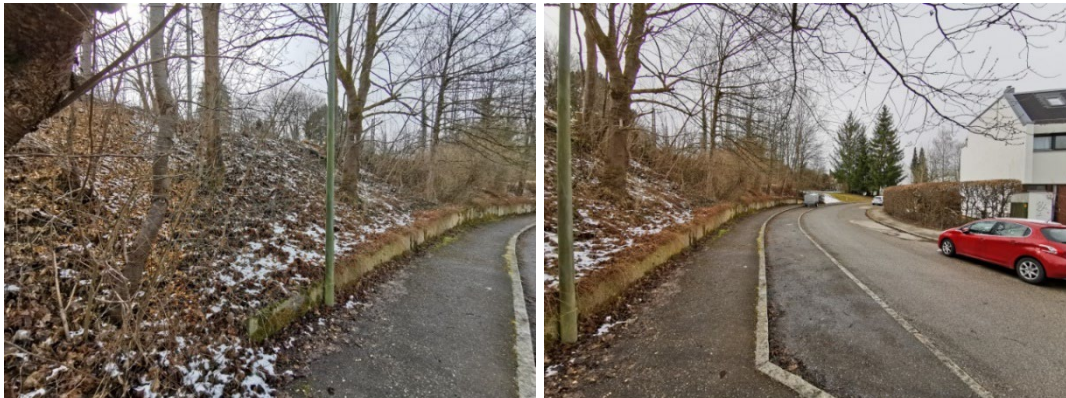
Abbildung 12: Stützwand „Am Katzenstein“
